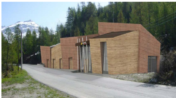
La centrale di teleriscaldamento
